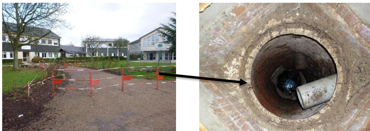
Puits d'infiltration
