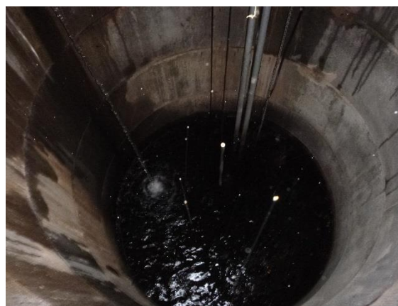
Ouvrage enterré de 15 \text{ m}^3 avec un débit de fuite assuré par un système de pompage
