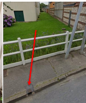
Exutoire rue de la Gare
